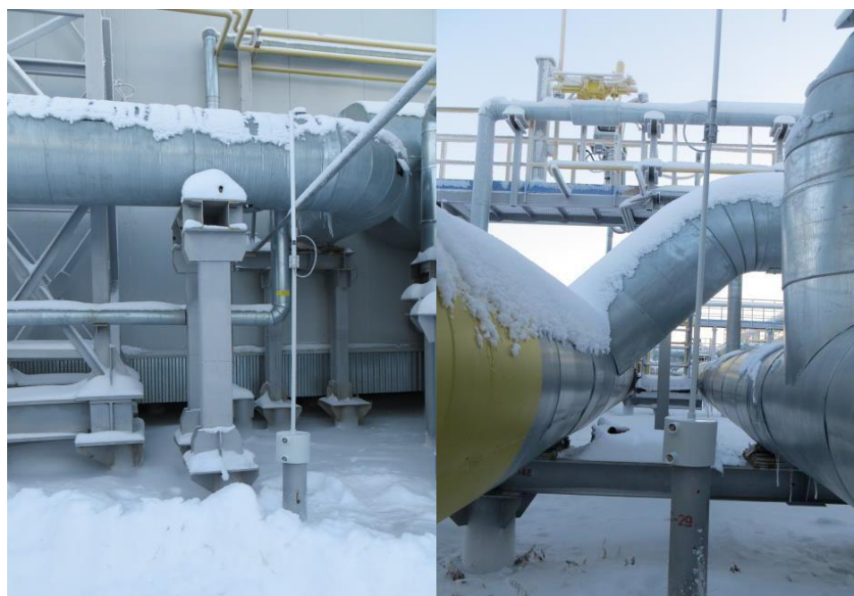
Рис. 11 – Дожимная компрессорная станция Медвежьего НГКМ
