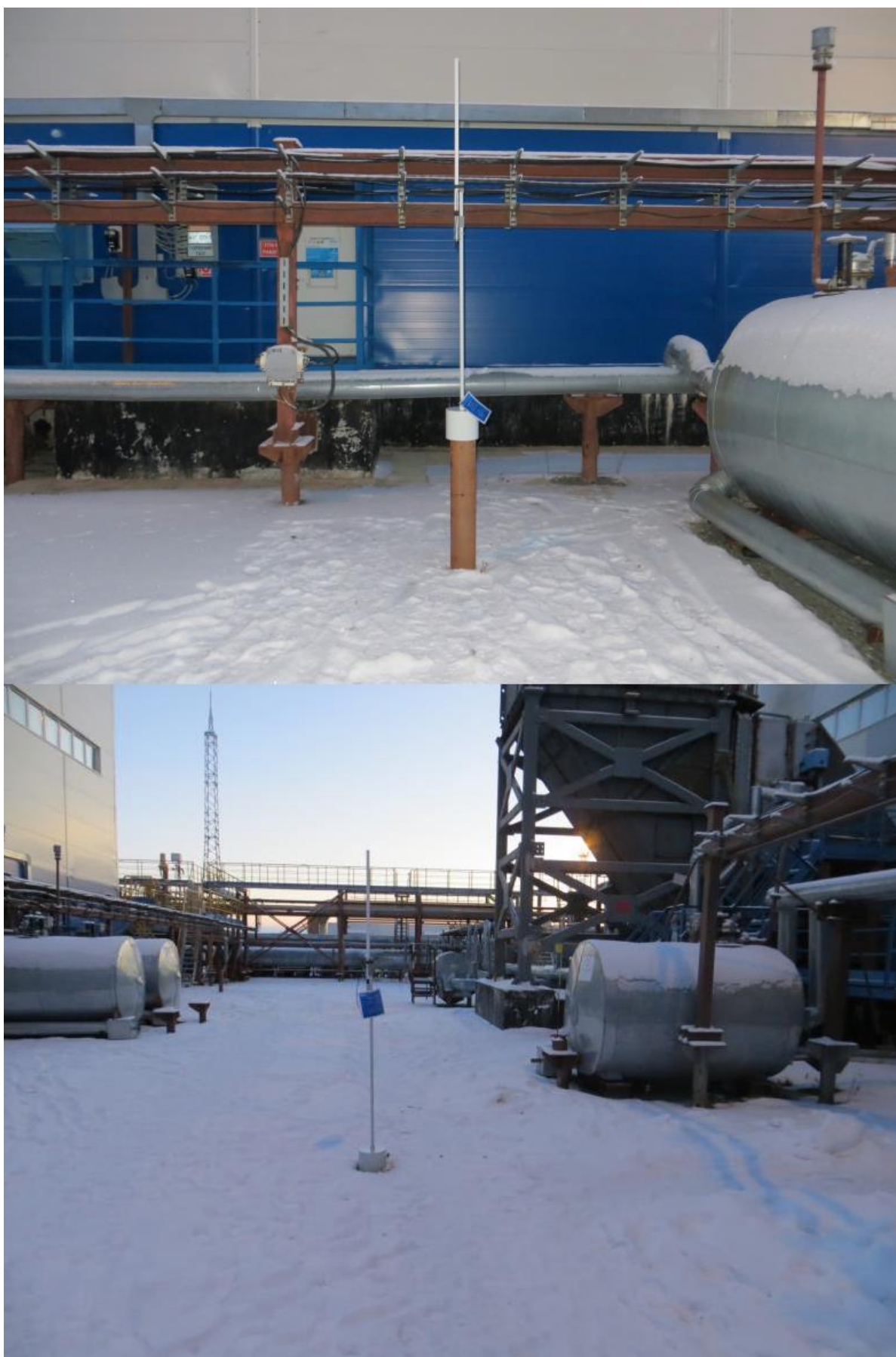
Рис. 12 - Дожимная компрессорная станция Юбилейного НГКМ
