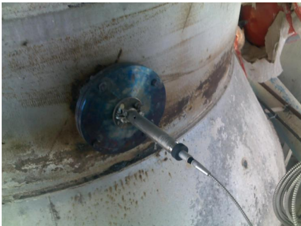
Рис. 2 Место установки пирометра 2.
